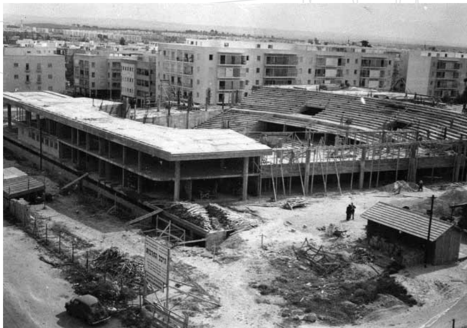
היכל התרבות בבנייה (צילום: פריאור) ארכיון התצלומים ע"ש מאריי ס' כץ, התזמורת הפילהרמונית הישראלית The Auditorium under construction (Photo: Prior) Murray S. Katz Photo Archives of the IPO
